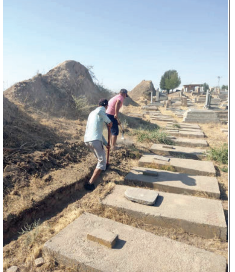
На территории кладбища постоянно ведутся работы.
