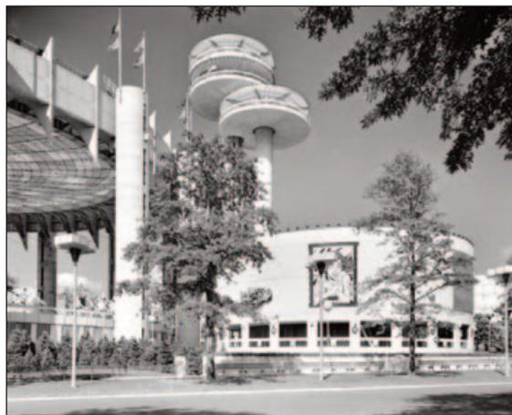
чать гидроизоляцию оснований башни, замену лестницы, модернизацию электрооборудования и работы по консервации конструкций на наблюдательных вышках.
