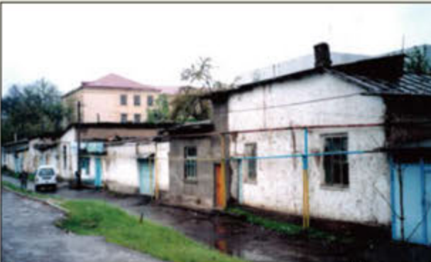
Ташкент ул. Хизматчи
