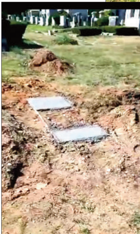
Это заливка экспериментальным методом 60"×24" из них 30"×24" засыпана земля для экономии. Сам контейнер размером 28"×87"
