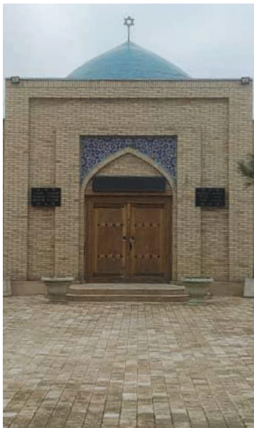
Уложена кирпичная кладка к центральному входу еврейского кладбища Бухары
